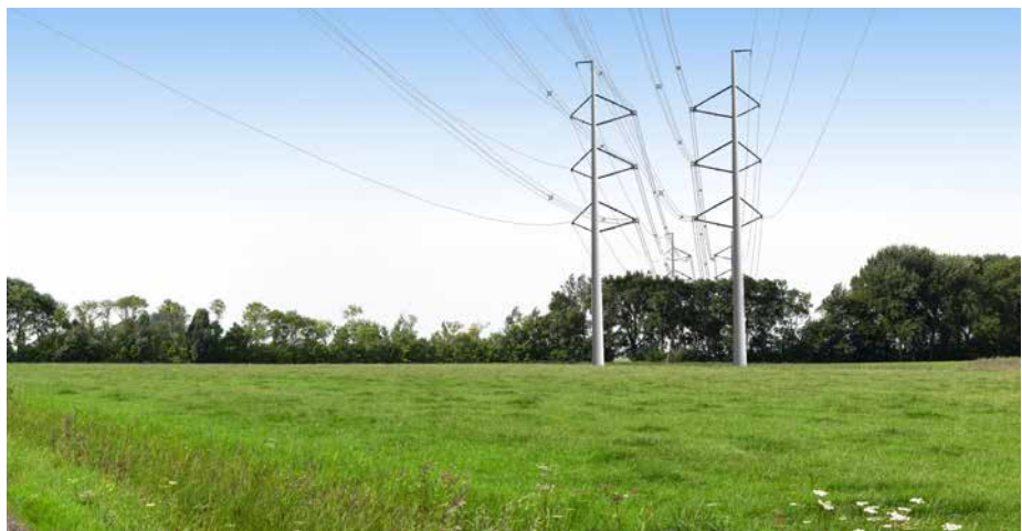
De combinatiemast met een 150 kV- en 380 kV-verbinding.
